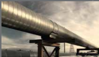
Boru hattı döşeme sahasında
